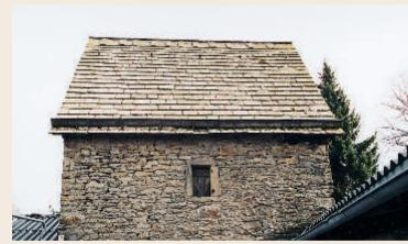
Das Dach ist mit Sandsteinplatten gedeckt. Diese aufwändige Art der Deckung kommt häufiger in der Gegend vor, so trägt auch das Langhaus der Syburger Kirche ein Sandsteinplattendach. Die schweren, ca. 3 - 4 cm starken und durchschnittlich 50 x 120 cm großen Steinplatten dienten als Brand-, Wärme- und Kälteschutz. Zwei Plattenlagen übereinander auf Fuge gelegt benötigen einen besonders stabilen Dachstuhl mit spitzem Dachneigungswinkel, damit Pfetten und Sparren das Gewicht der Steine tragen.
